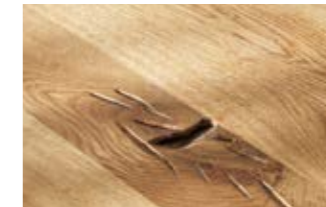
Offene Äste/Risse ausgeschliffen
